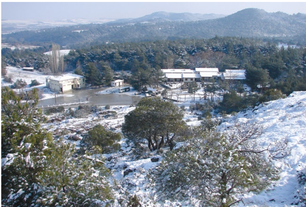
Κτήριο Φορέα Διαχείρισης και Ξενώνας Φωτ.: Πέτρος Μπαμπάκας - αρχείο Φορέα Διαχείρισης Ε.Π. Δάσους Δ.Λ.Σ.
